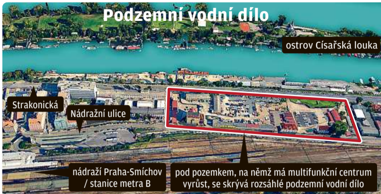
Vzhledem k bezpečnostnímu významu jde o utajené vodní dílo, které není ani zakresleno v katastru. Vzniklo v 80. letech při výstavbě metra B.
